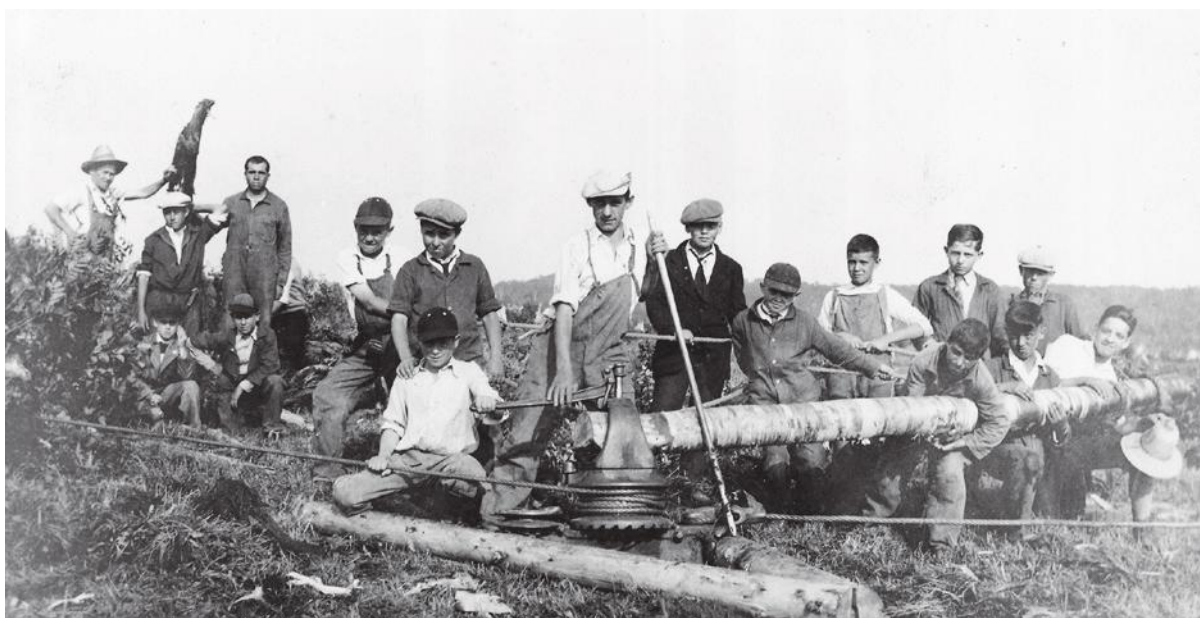
Les pensionnaires accompagnés des responsables aux travaux de la « Ferme Etchemin ». Au centre, le « cabestan » utilisé pour arracher les grosses pierres et les souches. Coll. Frères de l'Instruction chrétienne.
