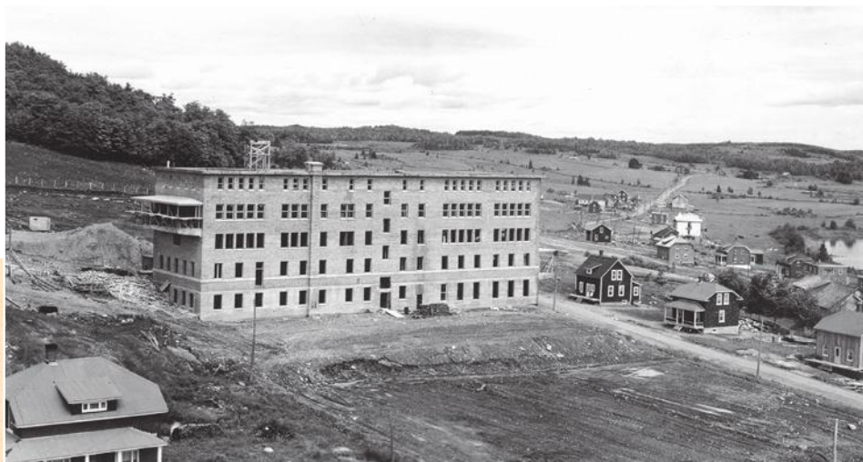
L'École ménagère en construction. Photo prise en 1948. Coll. Josette Turmel.
