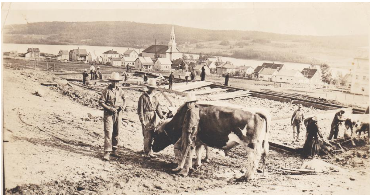
Construction de la première étable en 1934.
